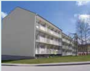
12, 13 rue des Charrières (36 appartements)
