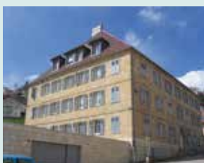
3, rue Frainier (13 logements)
